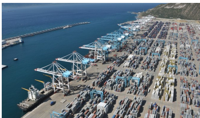
Le port de Tanger-Med (source : www.tpma.ma )
